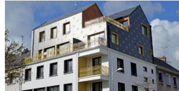
Figure 3 : Le Guérandais – Ière rénovation exemplaire, réalisation 2017.
