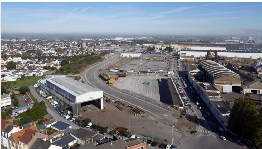
Le boulevard des Apprentis avant et après son dévoiement. Crédit Ville de Saint-Nazaire + Bruno Bouvry
