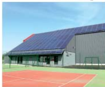
Des panneaux photovoltaïques ont été installés sur le gymnase.
