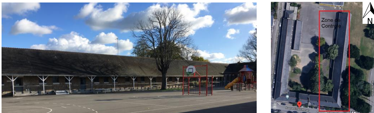
Figure 3: Photos des bâtiments de l'école Ernest Renan
